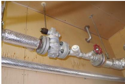
保温がされていない蒸気配管とバルブ
