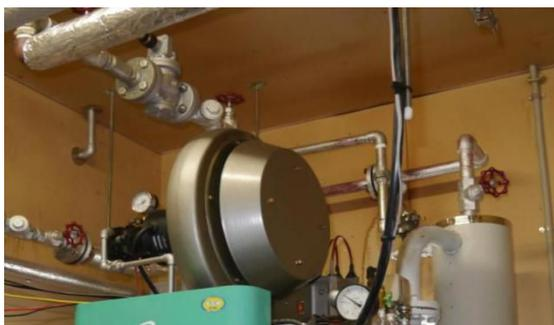
ボイラの保温がされていない蒸気配管
