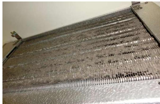
洗浄前 冷却器汚れで閉塞
